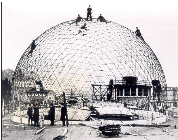
3. ábra: A jénai kupola szerkezetépítés közben
