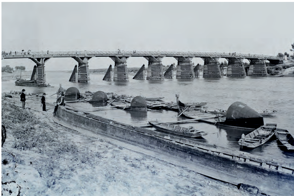
A szolnoki Tisza-híd építése 1900-ban
